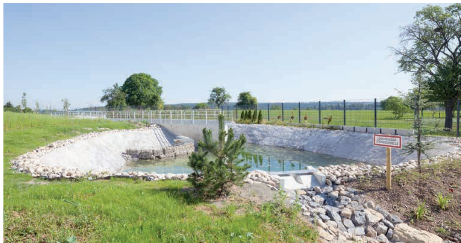
Bestmögliche Integration in das Stadtbild: Der Löschwassertank wird zur prägenden Teichanlage
