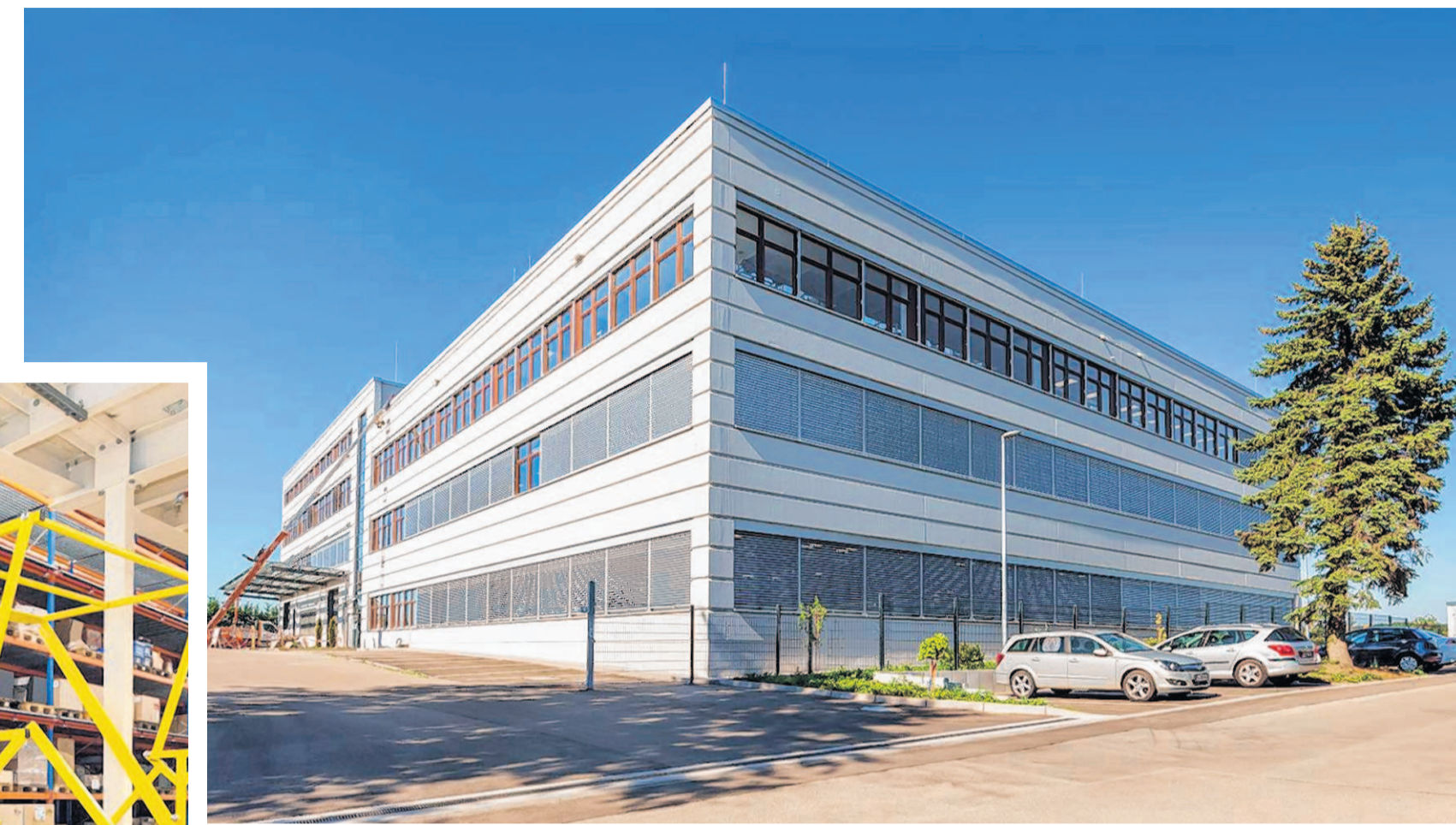
Das neue Produktions- und Lagergebäude in Maichingen ist bezogen. Solaranlagen auf dem Dach versorgen die Infrastruktur des Hauses.
